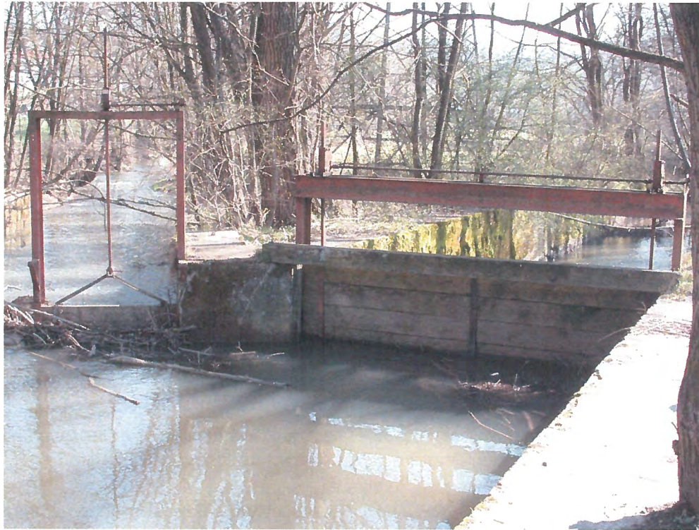
Abbildung 5: Ausleitung mit Stellfallen zum Mühlekanal
