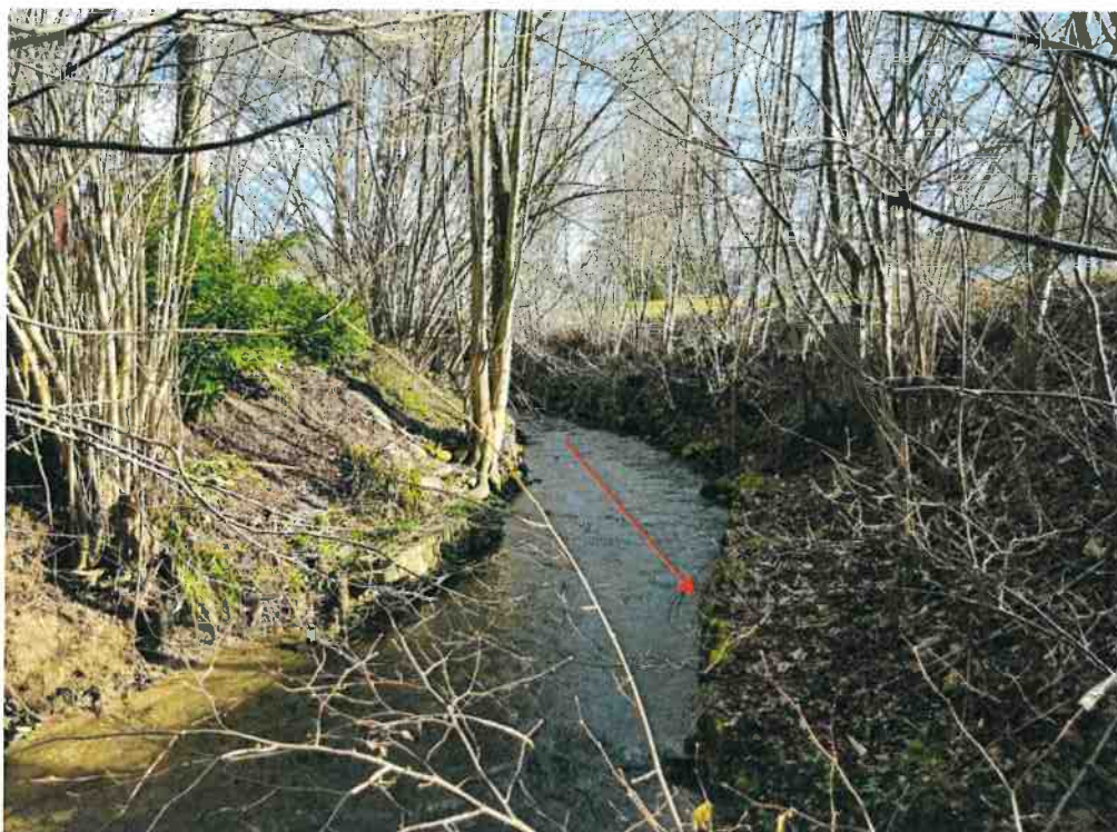
Abbildung 9: Blick den Hohlebach aufwärts; Das linke Ufer wurde hier im Vordergrund (roter Pfeil) mit einer ca. 50 cm hohen Mauer befestigt
