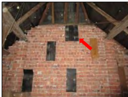
Abb.7:Gebäude Nr. 4 mit Kotspuren von vermutlich Tauben sowie Verschluss mit Brettern und Kaninchendraht
