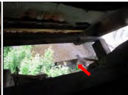
Abb.7:Gebäude Nr. 4 mit Kotspuren von vermutlich Tauben sowie Verschluss mit Brettern und Kaninchendraht
