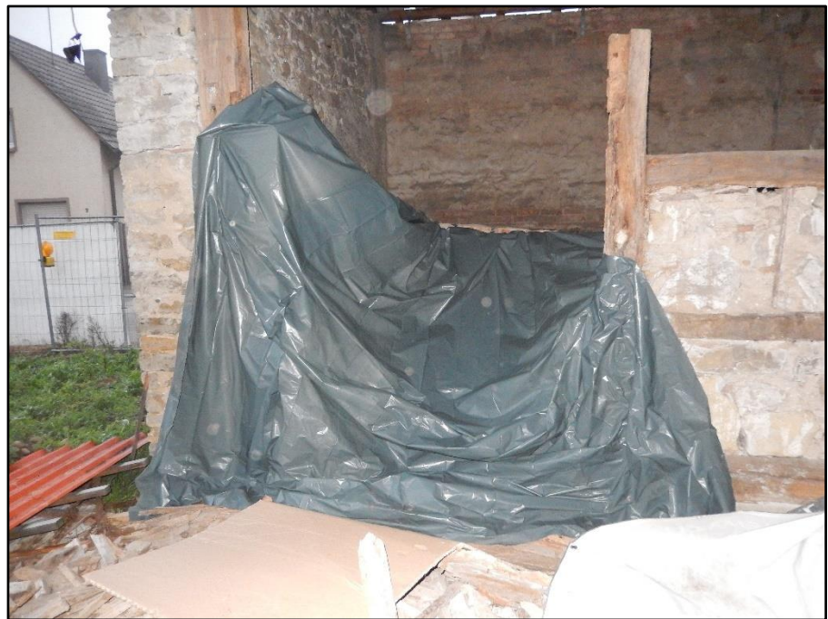
Foto 2: Der Eingang zum besatzfreien Gewölbe- keller wurde anschließend mit einer robusten Folie verschlossen.
