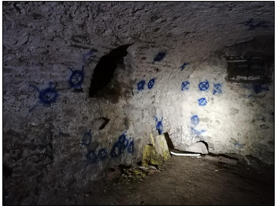
Foto 1: Der Gewölbekeller und die dort vorhandenen Mauerspalten (blau markiert) wurden (endoskopisch) auf Fledermausbesatz geprüft.
