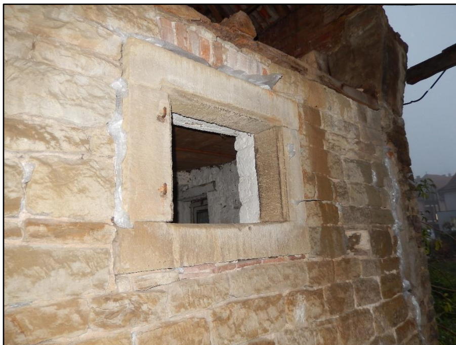
Foto 5: Einzelne endoskopisch einsehbare Spalten wurden nach der Besatzfreiheitskontrolle ebenfalls verschlossen.
