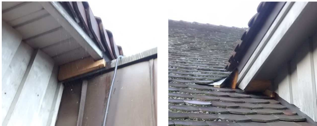
Abbildung 2: Mit Holzlatten versperrte Schlupflöcher zum Dachboden an den zum Dachgarten weisenden Dachgauben des ehemaligen Feuerwehrhauses.
