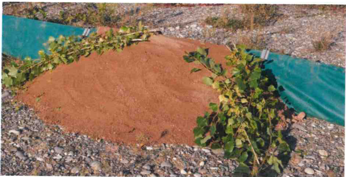
Abb. 5: Beispielhafte Überstiegshilfe, so konstruiert, dass der Zaun nicht beschwert wird (Quelle: BHM).
