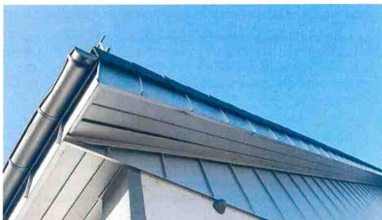
Abbildung 6: abstehendes Blech, am Dach des Gebäudes
